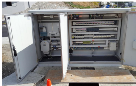
Abbildung 3: Bsp. Feld Abgänge und Steuerung
