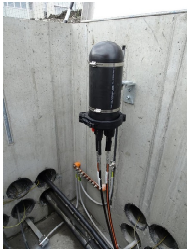
Abbildung 31: Bsp. LWL-Muffe in Elektroschacht
