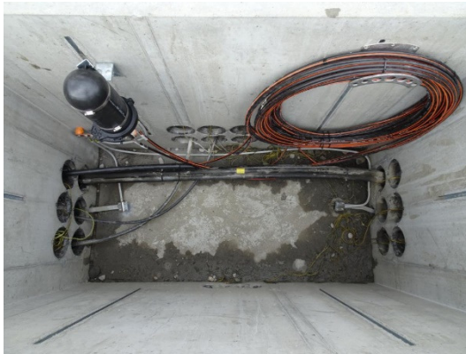
Abbildung 33: Bsp. Elektroschacht mit LWL-Muffe
