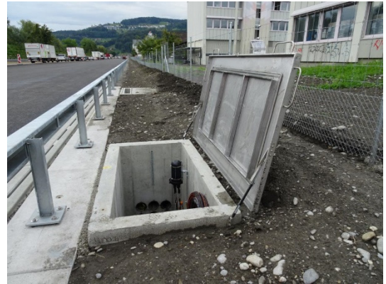
Abbildung 34: Bsp. Elektroschacht mit Leichtmetall-Deckel
